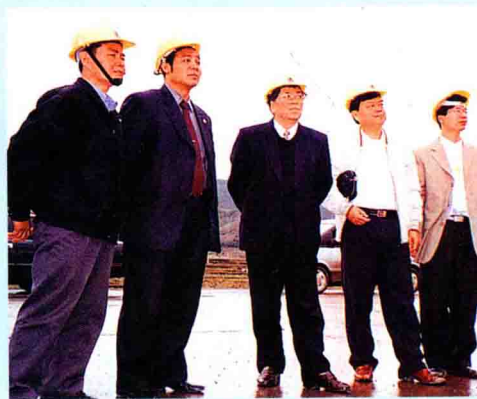
梅州供电局长陈金荣(中)深入蕉岭农网改造现场检查指导
