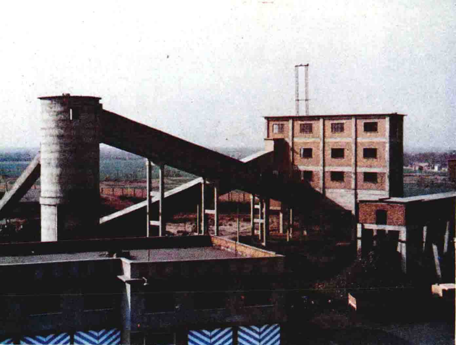
邢台地区磨窝煤矿工业广场——洗煤厂一角
