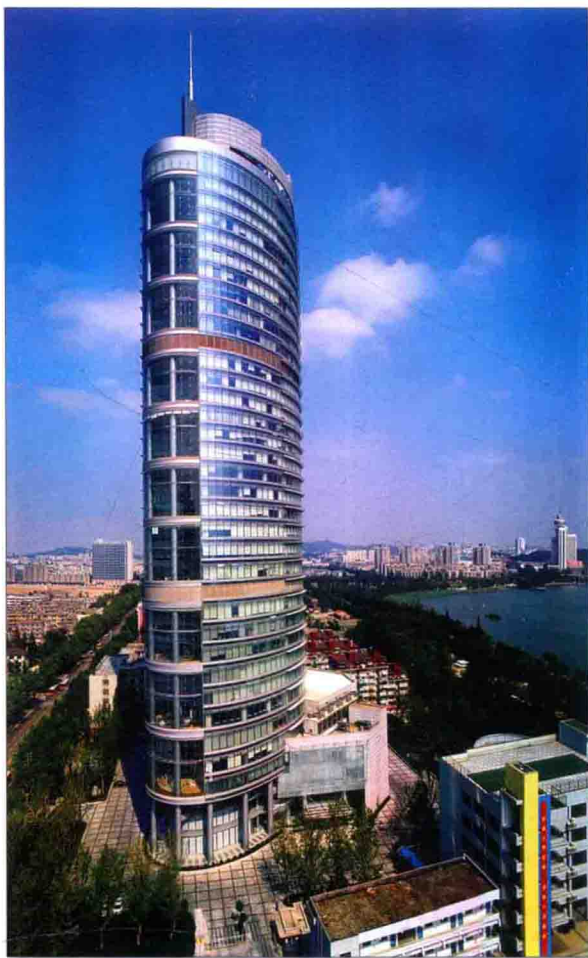
中央路省电信有限公司通信综合大楼
