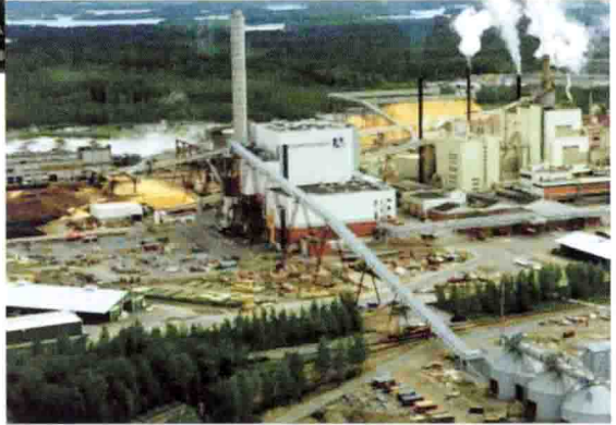
图 9 Alholmen Kraft 生物质能热电联产电厂（芬兰，240MWe）
