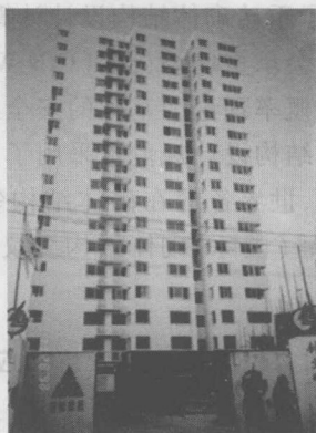
图1-7 上海配筋砌块剪力墙大楼
