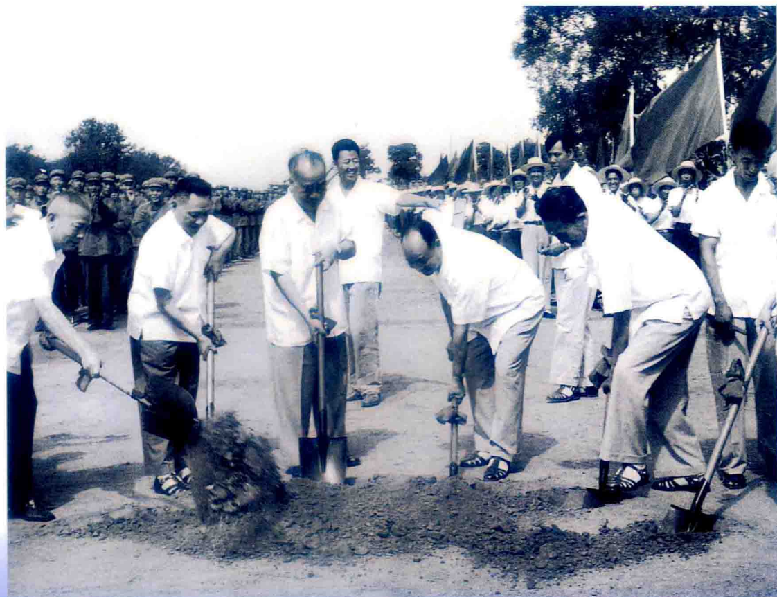
1965年2月4日，毛泽东就修建北京地铁批示，“精心设计，精心施工。在建设过程中，一定会有不少错误失败，随时注意改正。”7月1日，北京地铁举行动工典礼，朱德、邓小平、彭真、李先念等中央领导同志挥锹奠基。
