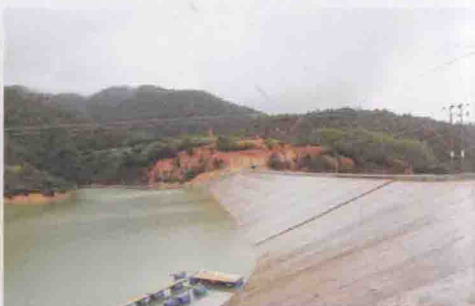
除险加固后的洲瑞白水礐水库
