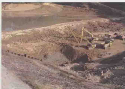
沐东水库除险加固现场
