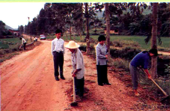
通过精心养护，全县地方公路年末好路率历年达 100%。图为站领导到第一线检查工作。
