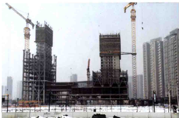
正在建设中的高层建筑
