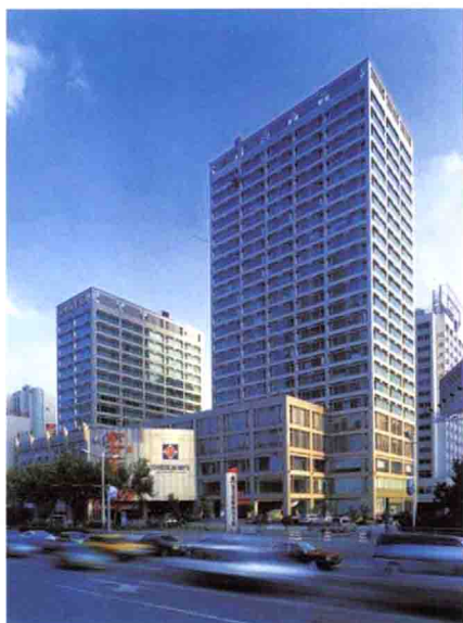
国内第一座全新钢结构高层建筑——杭州瑞丰际商务大厦(2003年建成)
