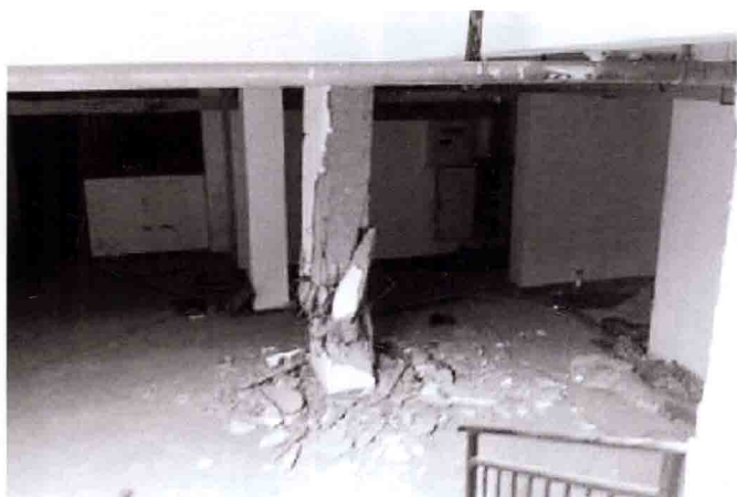
浙江省玉环县坎门街道一幢 18 层居民楼出现严重不均匀沉降,地下室一根框架柱被压碎(2011 年 11 月事故发生)。
