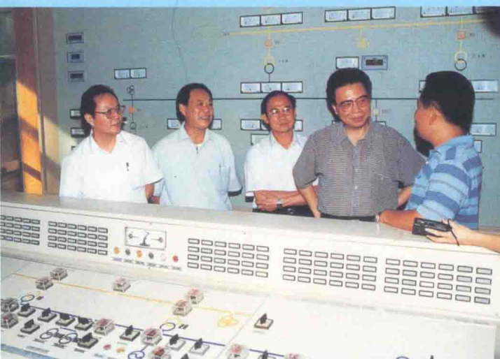
梅州市西阳拦河水电站四台机组发电 (黄新宇摄)
