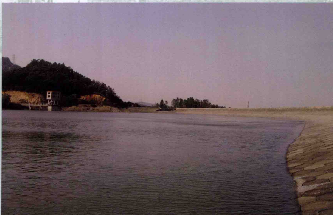
珠海南屏水库补淡蓄满状况
