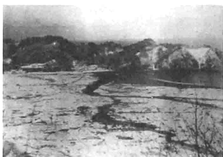
图 1.1 日本三陆地震后的地裂缝 [2]
