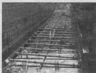
图 11 旋喷锚桩施工过程照片——开挖至槽底
