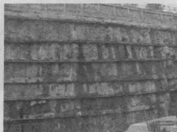
图 13 旋喷锚桩施工完成照片——开挖至槽底
