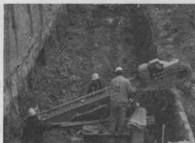
图 10 旋喷锚桩施工过程照片——首道锚桩施工
