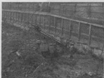
图 12 旋喷锚桩施工过程照片——首道锚桩施工
