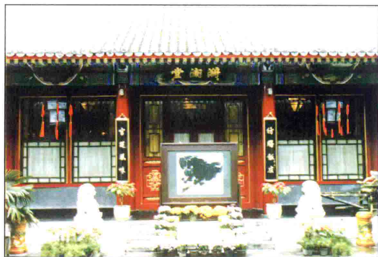
具有民族建筑风格的仿膳饭庄营业楼
