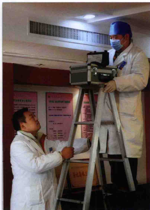
市疾控中心定期对集中空调送风系统卫生检测
