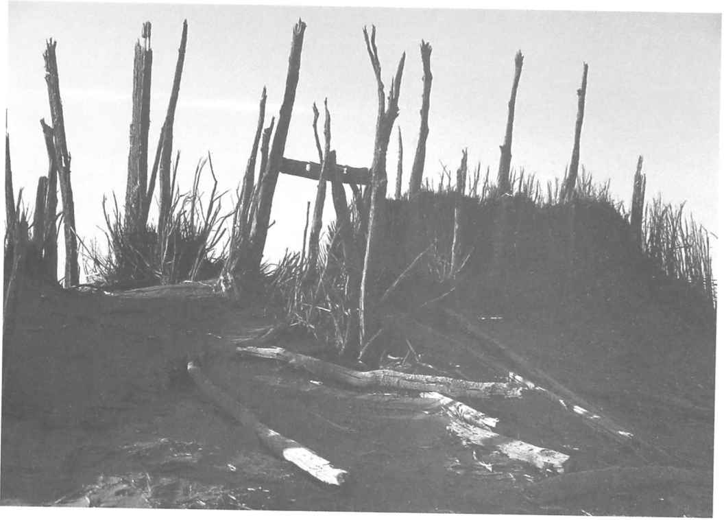
15. 楼兰残存的房屋木构架（二）
