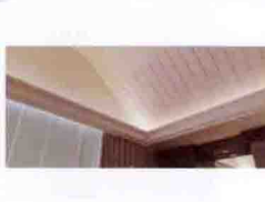
实例127 直型灯槽光效
