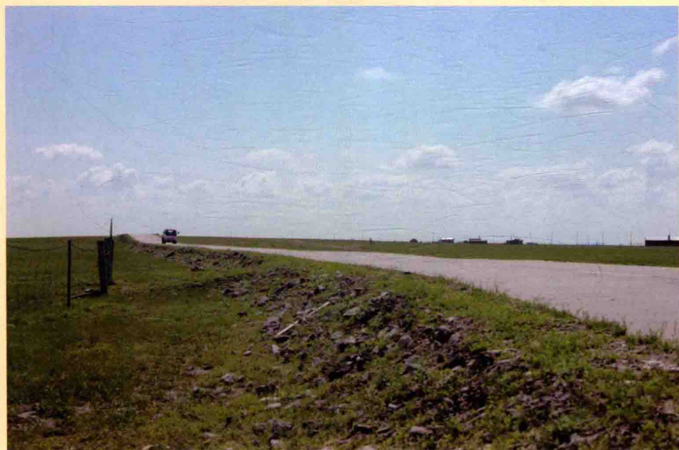
图6 新修建的进出嘎查的公路
