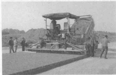
图 1-5 铺筑中的级配碎砾石路面
