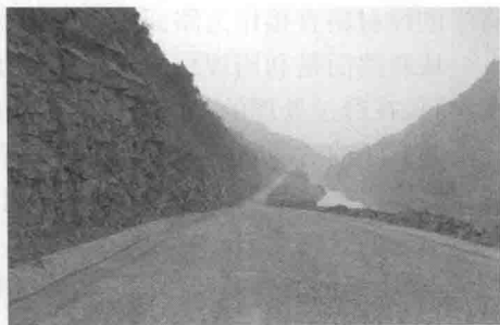
图 1-3 某无机结合料稳定路面
