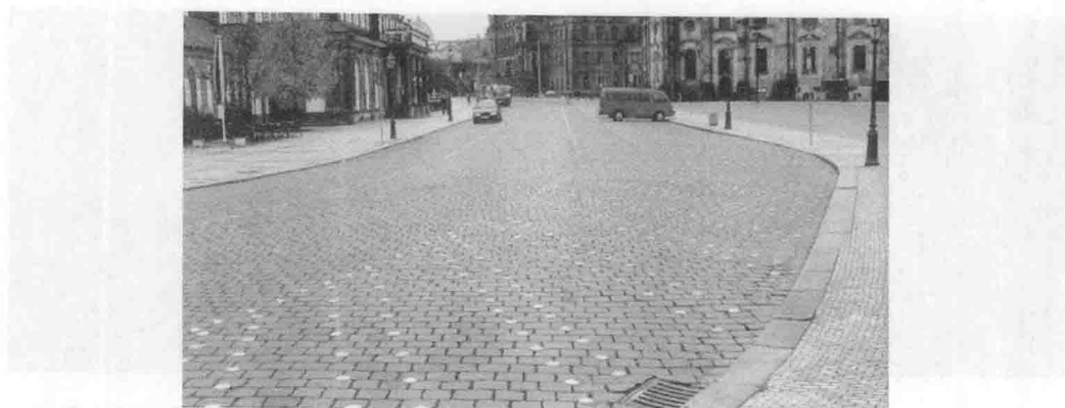
图 1-14 使用中的城市道路块料路面
