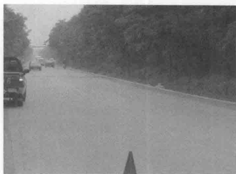
图 1-16 某二级公路的水泥混凝土路面
