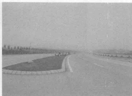
图 1-17 某高速公路的水泥混凝土路面
