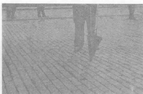
图 1-12 铺砖路面缝隙中灌注沥青的 施工情况
