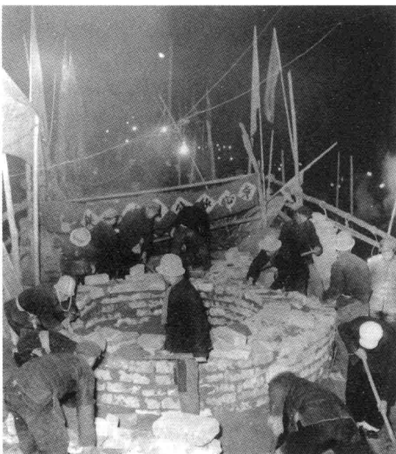
7、工业大跃进期间，呼和浩特北垣钢铁厂正在建设小高炉。
