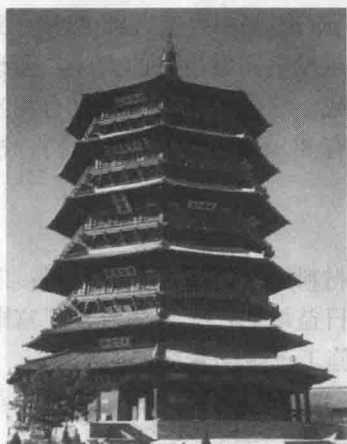
图 1-5 山西应县木塔
