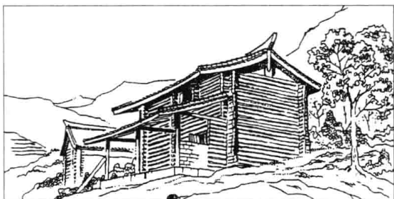
云南南华马鞍山井干式住宅
