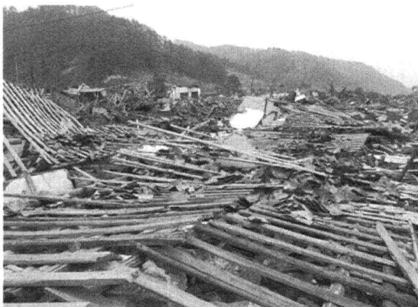
图 1-7 汶川地震中成片倒塌的村镇房屋
