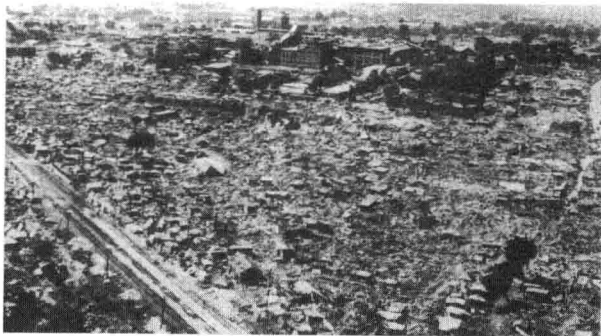
图 1-3 唐山地震极震区房屋几乎全部倒塌
