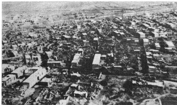
图1-1 邢台地震中村镇房屋大面积倒塌
