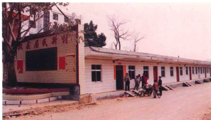
2004年9月30日开始动工兴建安置双头灾民的居民新村（共有住房70套），2005年春节前，重灾户搬进新居。
