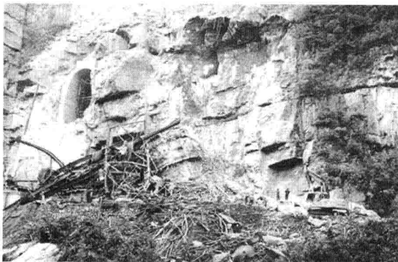
图1-2 宜万铁路巴东段高阳寨隧道口发生岩崩
