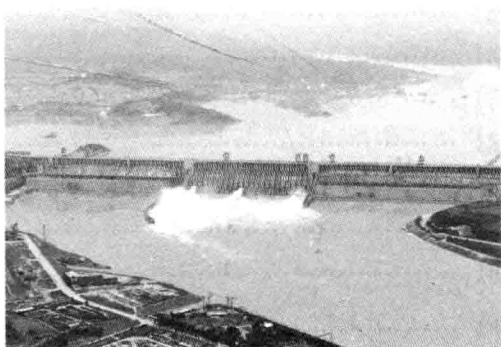
图 1-4 长江三峡水利枢纽工程
