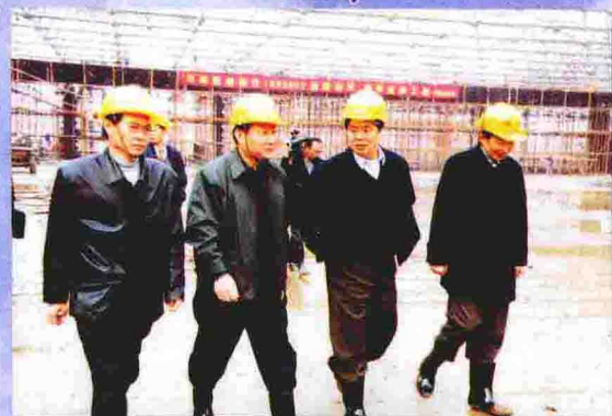
市长王宏民、副市长奚永明在厂长张岩磊陪同下视察新厂建设工地。
