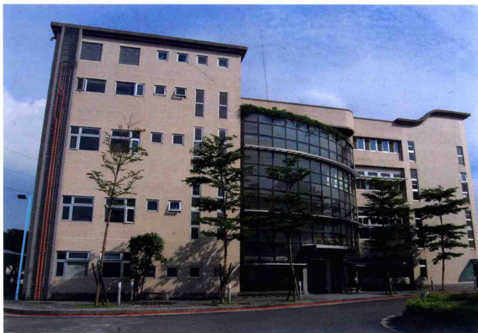
抽水站自動化監控系統總管理中心。
