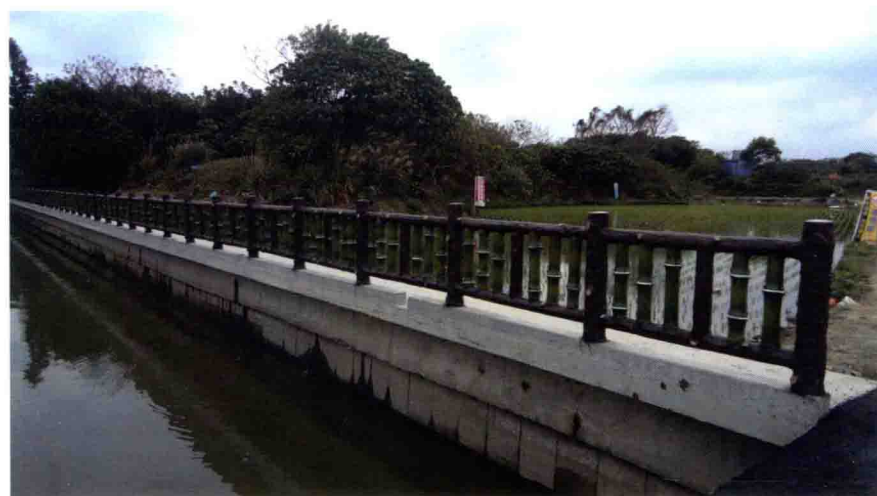
北投橫路溝除了排水外，更維護生態環境。
