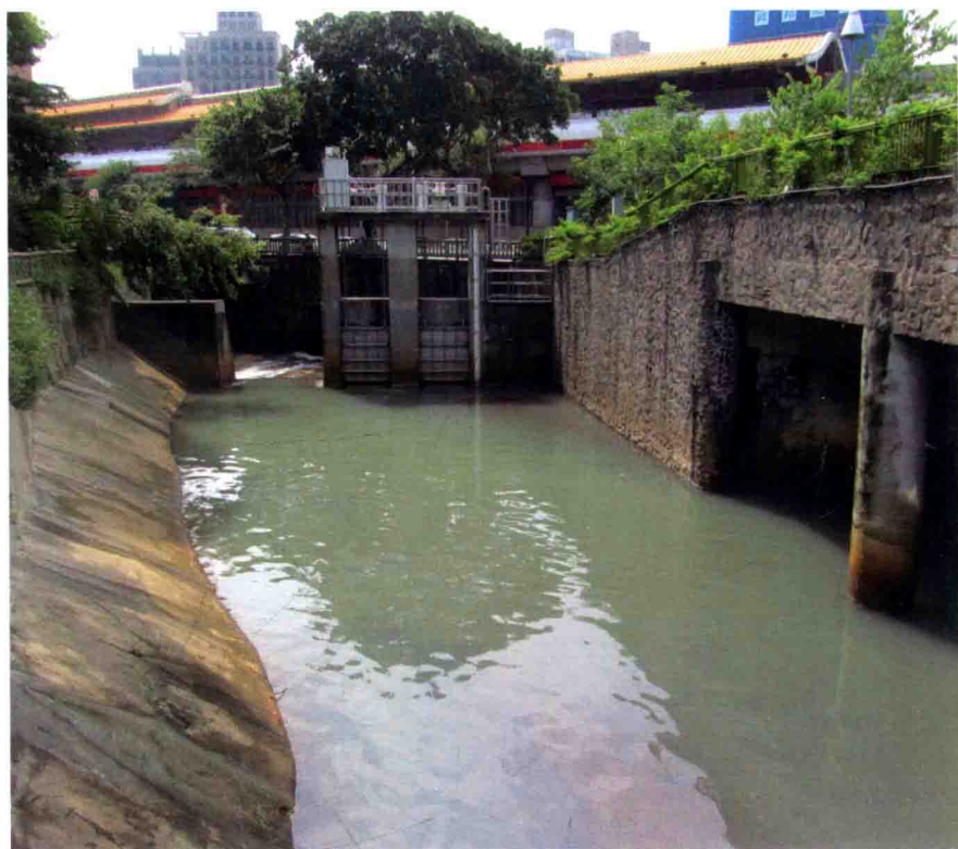
磺港溪分洪工程以疏導方式治理洪水，解決沿岸淹水問題。
