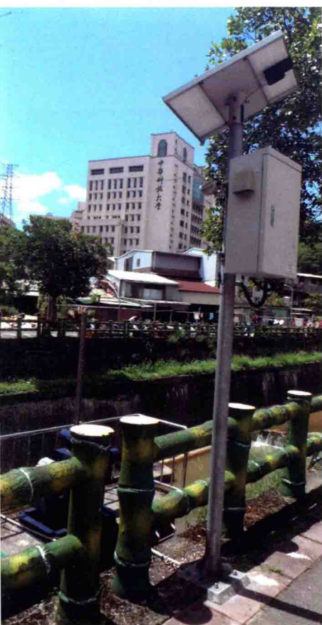
以太陽能為動力的雨水下水道水位計。
