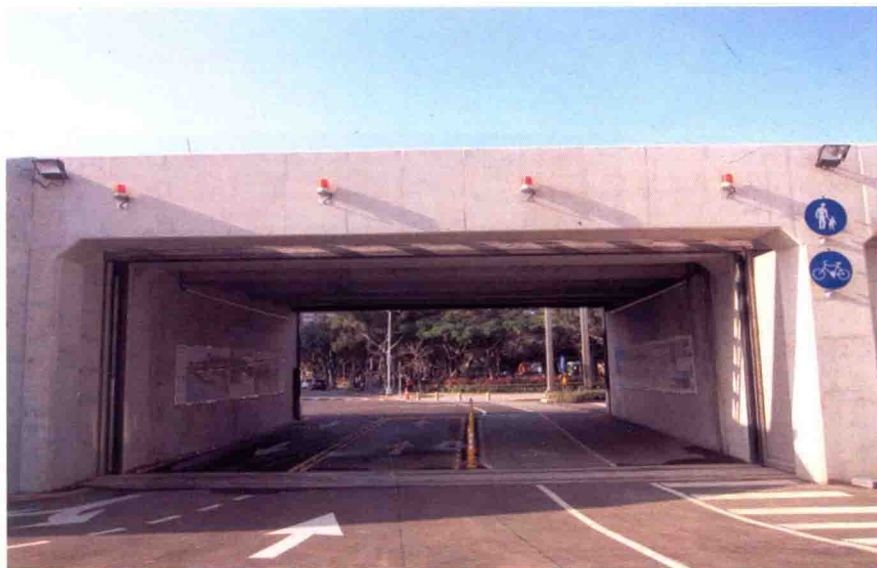
新1號（馬場）疏散門是市區與河濱公園的重要連通管道。
