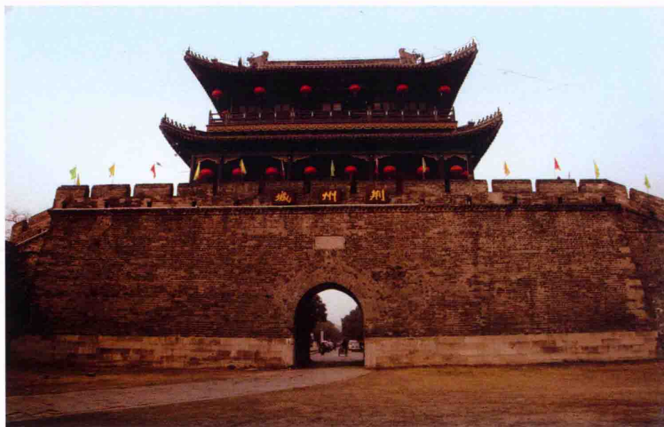
荆州宾阳楼 始建于明代，位于湖北省荆州市
