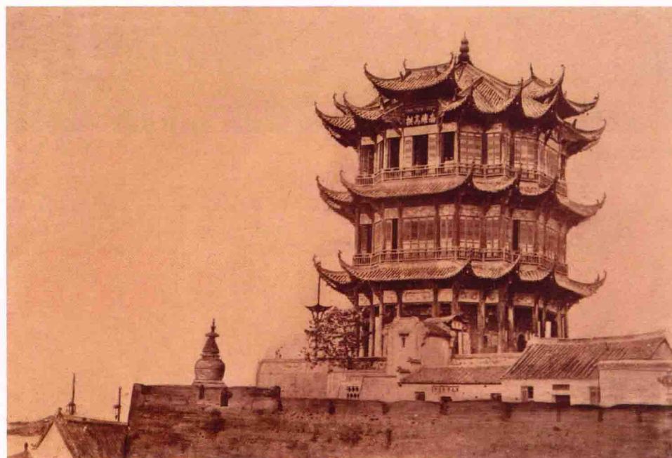
清同治年间黄鹤楼原貌
