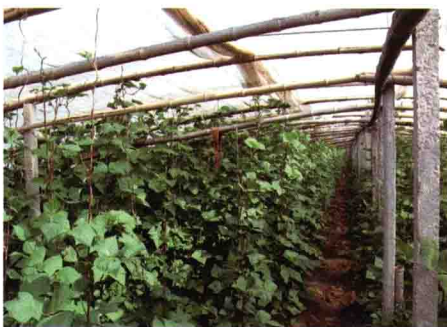
● 彩图 5 竹木水泥混合结构大棚
