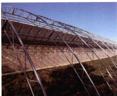
● 彩图7 装配式钢骨架温室
