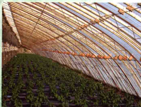
● 彩图25 钢管竹木混合结构温室
