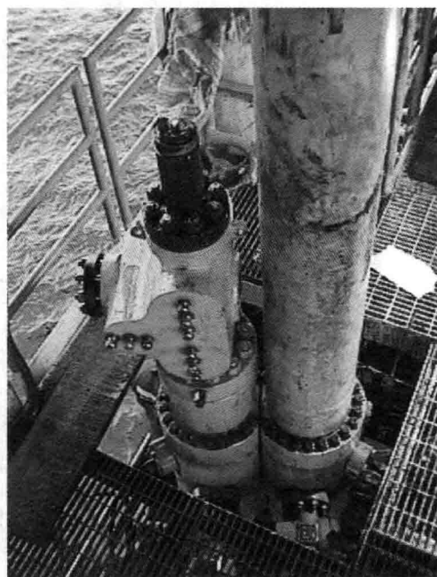
图 1-9 30in 隔水导管安装两个 11in 套管头现场实物图
