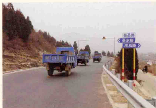
12月3日，韩村河镇岳圣路复线竣工通车。
