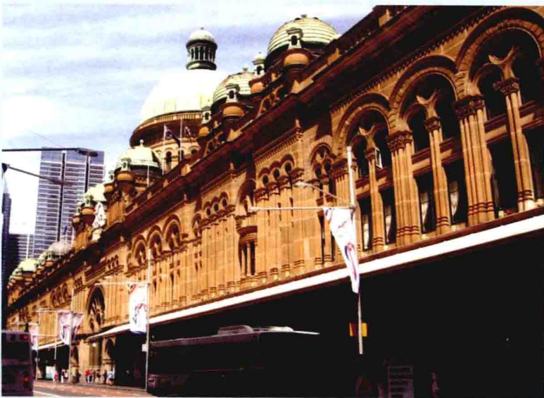
✧ 邮政总局大楼
