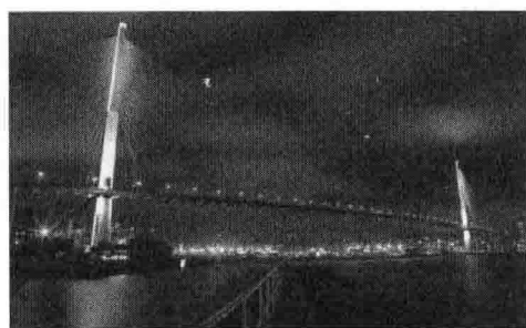
a) 独柱式索塔(香港昂船洲大桥)
