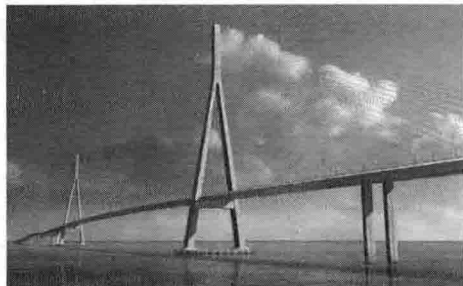
f) 倒Y形塔(苏通长江大桥)
