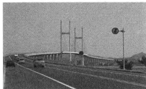
c) H形索塔(山东威海长会口大桥)
