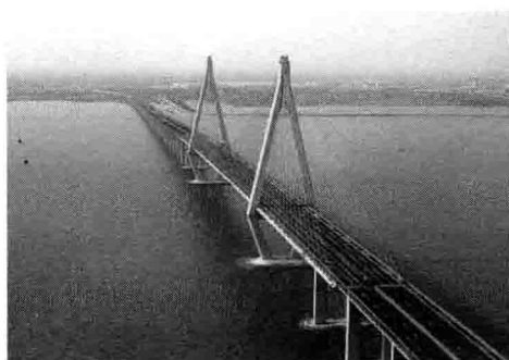
i) 钻石形索塔(杭州湾跨海大桥北航道桥)
