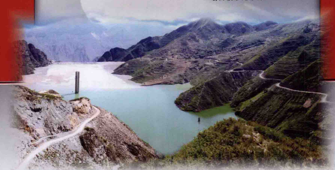
峨口铁矿尾矿库
