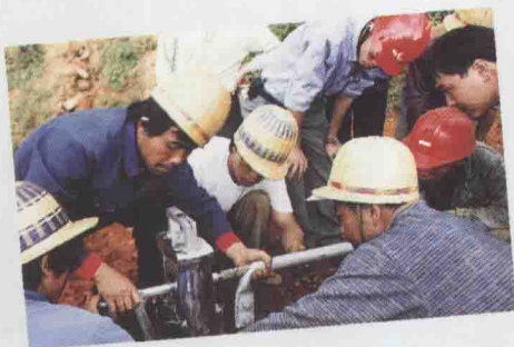
全省20个农网建设改造试点县之一的东川区农网改造施工现场一角
