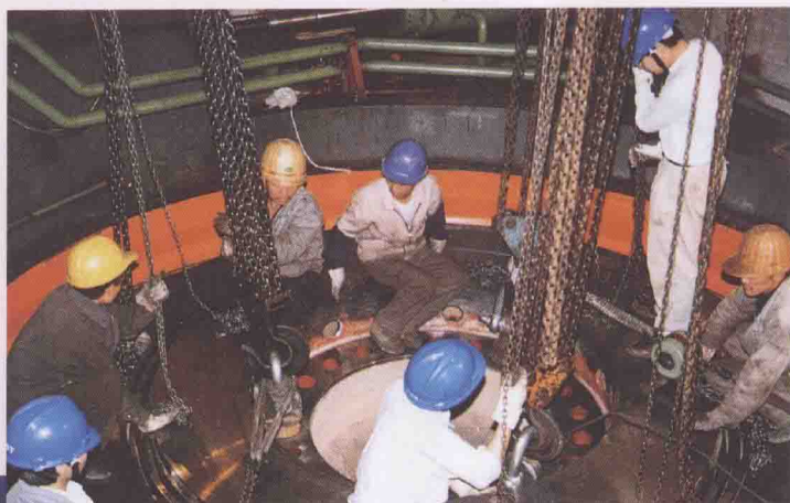
鲁布革发电总厂对水轮机进行大修
