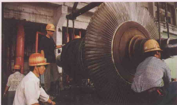
巡检司发电厂检修人员精心吊装大修好的二号 汽轮机转子
