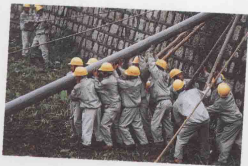
1999年5月25日富民者北变电所工程启动标志着昆明电网农网改造工作全面展开
