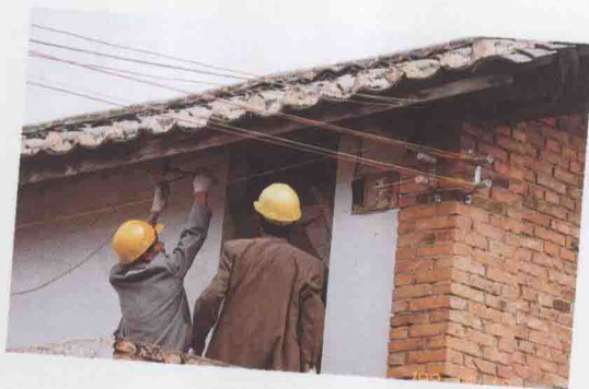
个旧供电局在进行一户一表改造
