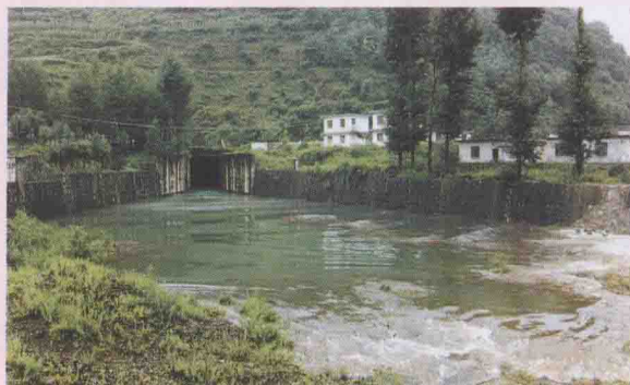
以礼河发电厂毛家村水库建成40余年后的第一次泄洪
