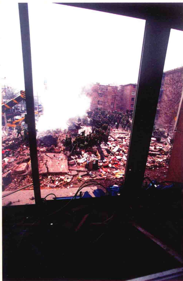
▲3月16日清晨4时许，石市棉纺三厂宿舍16号居民楼发生爆炸，变成废墟一片。
