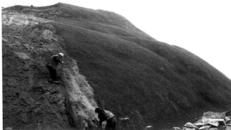
图 1.1 铺草皮护坡技术
