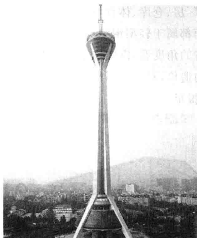
图 1.8 四川广播电视塔
