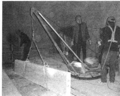
图 0-7 预制空心楼板吊装照片
