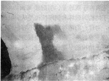
图 0-4 贴壁式被覆洞库被覆层漏水和渗水照片
