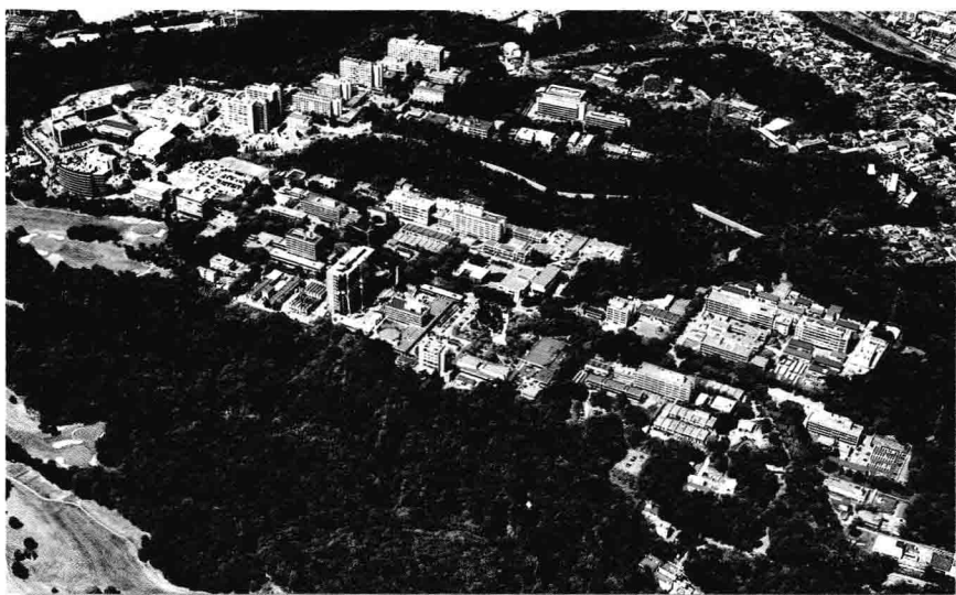
1 青葉山地区 平成 16 年
