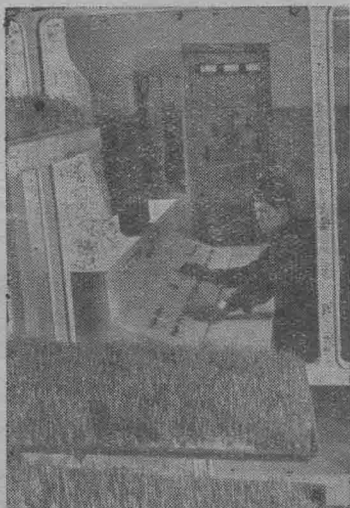
湖北省咸宁地区建成一座电力控制的机械化无土育秧室，初步实现了育秧工厂化。这是育秧电控室在工作。
