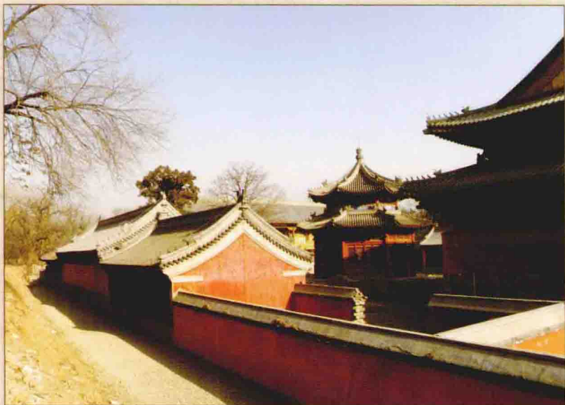
正在修复的圆明园正觉寺
