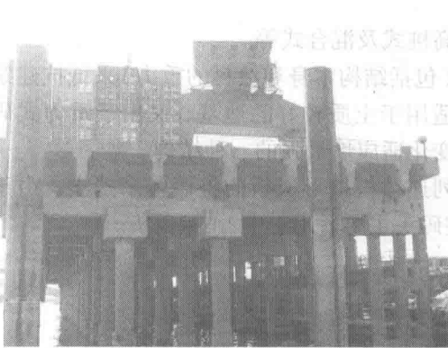
图 1-9 高桩码头横断面图
