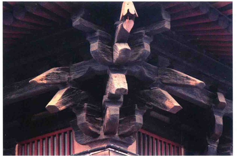
图一〇 摩尼殿外檐转角铺作
