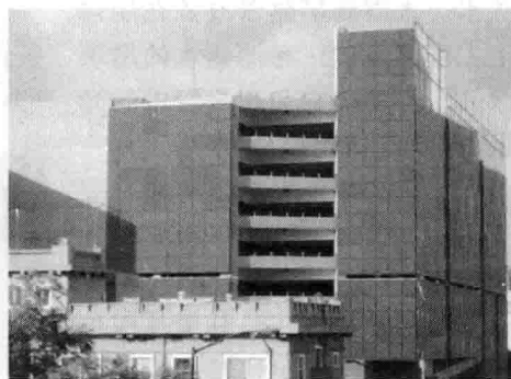
图 1-10 位于加利福尼亚州圣迭戈的一个 40kWp 商业化并网光伏系统。由于屋顶用作停车场，光伏组件垂直安装（来源：Global Sustainable Energy Solutions）
