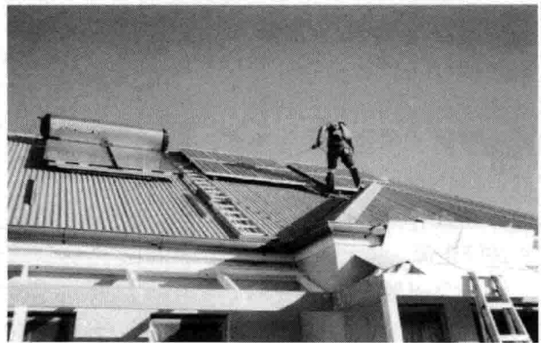
图 1-3 一名电气工程师正在安装太阳能系统，左侧是太阳能热水系统，右侧是太阳能发电系统（来源：Global Sustainable Energy Solutions）
