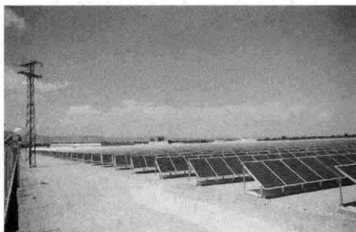
图 1-9 西班牙阿里坎特 5.6MWp 集中式光伏系统（来源：SMA Solar Technology AG）
