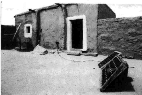
图 1-5 对于生活在类似西撒哈拉（该系统所在地）的发展中国家农村地区的人们来说，小型离网太阳能发电系统通常是最便捷、最具成本效益的供电方式（来源：Global Sustainable Energy Solutions）
