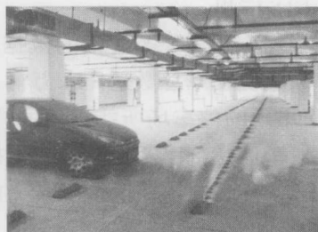
图 1-2 三亚城区地下停车现状
