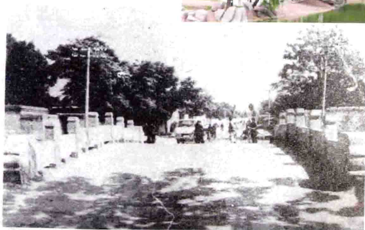
驾桥（响水桥）桥面旧影
