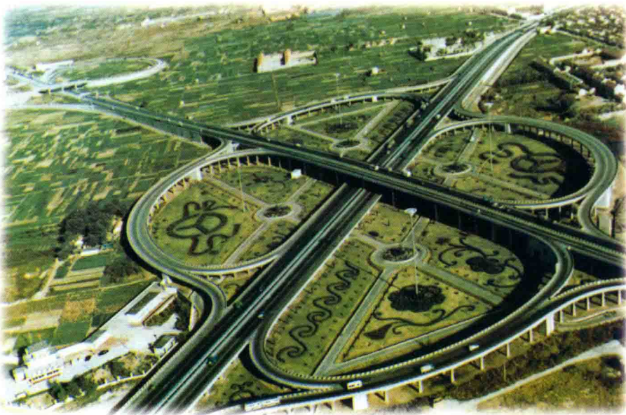
流亭公路立交桥
