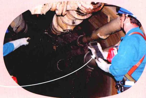
下水道工人们用这种能与电脑连起来的小机器检测下水道的情况，这样他们就可以快速地知道哪个地方需要清理了。
